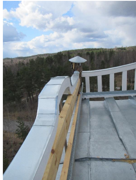
Överliggarna tappade in i stolparna, som tidigare. Underliggare skråskruvade i stolparna. Spånen återmonteras runt stolparna. Plåttäckningen falsad och monterad med klammer på traditionellt vis
